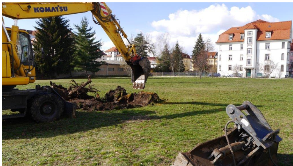
Beginn der Bauarbeiten für die Container auf dem Campus
