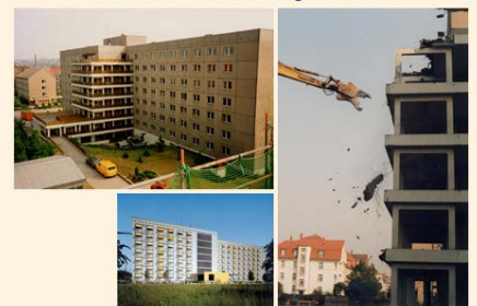
Bau / Außensanierung Haus 3
